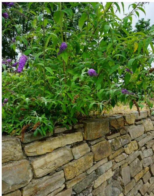
Figuur 5. Groei van vlinderstruiken op de muren is ongewenst, omdat het de muren beschadigt en beschaduwing veroorzaakt.
