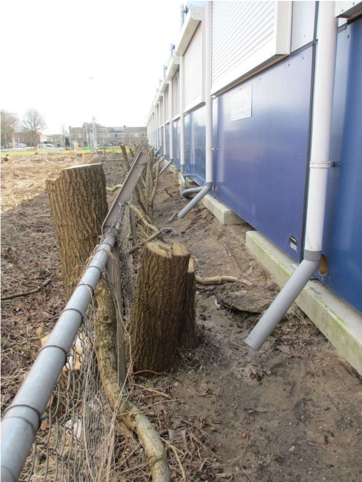
Hier is duidelijk te zien dat de tijdelijke school is gebouwd op een opgebrachte losse laag grond
