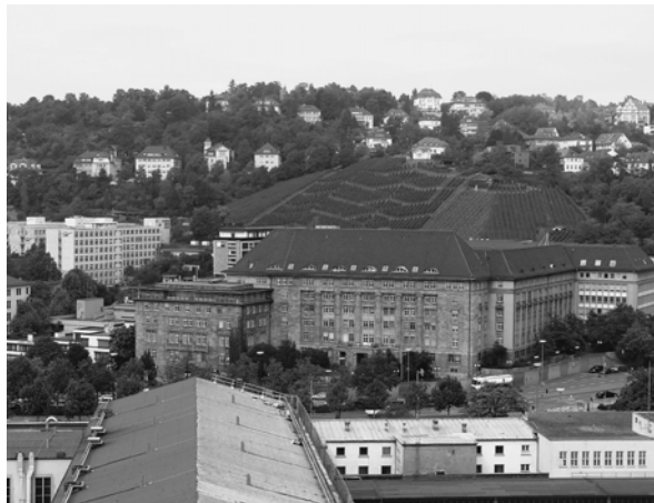
Abb. 5: Kriegsberggebiet (Z1) vom Bahnhofsturm aus. Historische Aufnahme von 2008 vor Beginn der Abbrucharbeiten zur Umgestaltung des Stuttgarter Hauptbahnhofs. Foto: G. DEICHSEL. Kriegsberg district (Z1) as viewed from the Central Railway Station tower. Historic photograph of the year 2008 before the demolition works for the re-construction of the station building.
