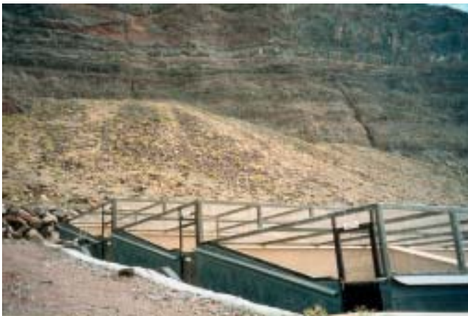
Abb. 3. Der obere Teil der Außenanlage.
