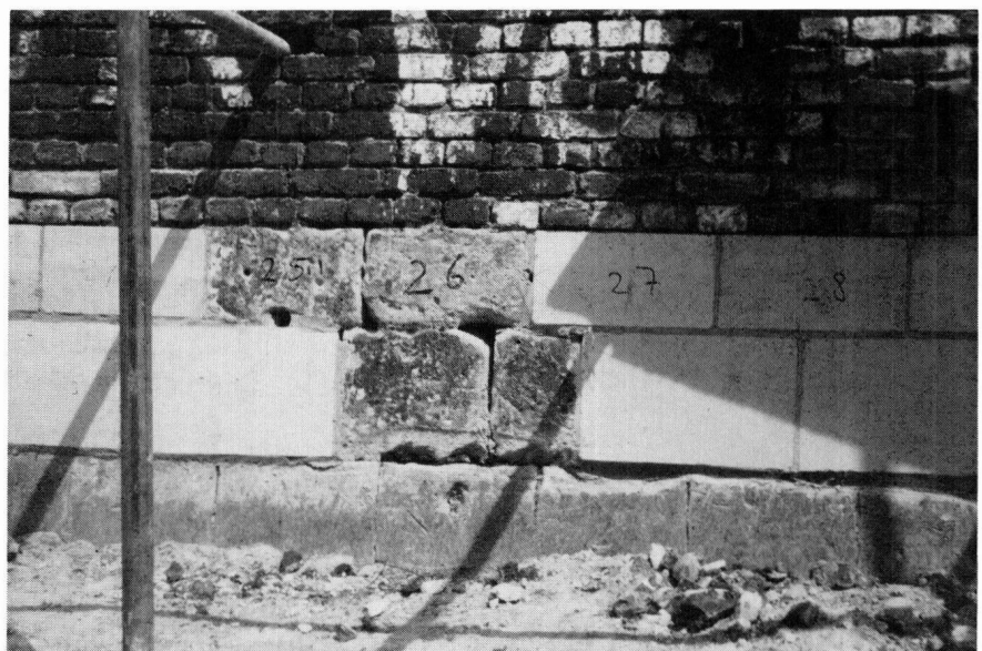
Figuur 10. Beter voorbeeld van restauratie: tijdens de restauratie in de Hoge Fronten werden slechts bij één enkele muur hier en daar oude mergelblokken gehandhaafd, waardoor enkele winterholletjes gespaard bleven (foto: B. Kruyntjens, 1981).
