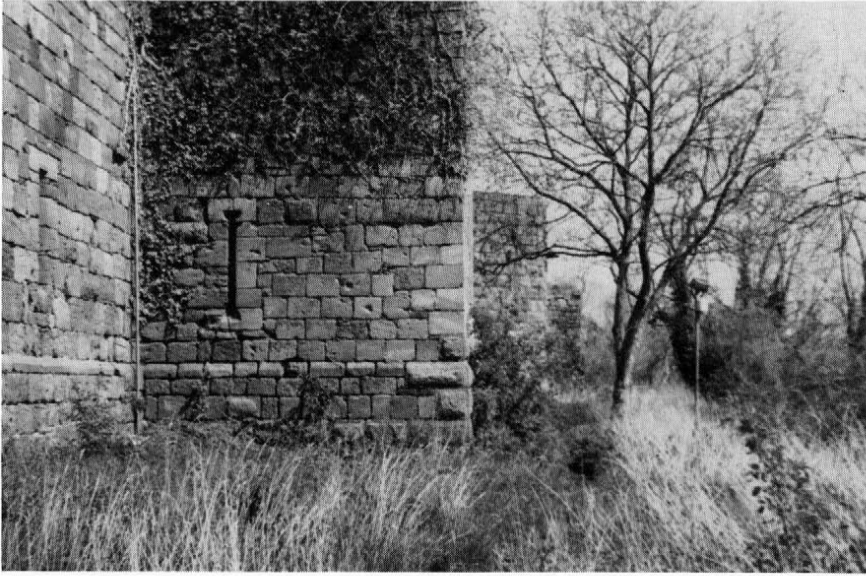
Figuur 11. Zuidmuur van de burcht in Nideggen die in het kader van restauratie in de 70er jaren alleen van overmatige begroeiing is ontdaan (foto: R. Prick, 1989).
