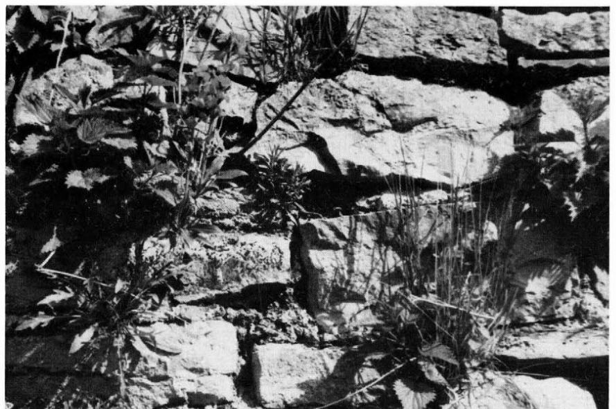
Figuur 12. Goed voorbeeld van restauratie: deze gerestaureerde (!) 'Bruchsteinmauer' — een met breukstenen gemetselde muur — in Kornelimünster met vele holletjes en muurvegetatie vormt nog steeds een ideaal leefgebied voor een populatie Muurhagedissen (foto: R. Prick, 1989).
