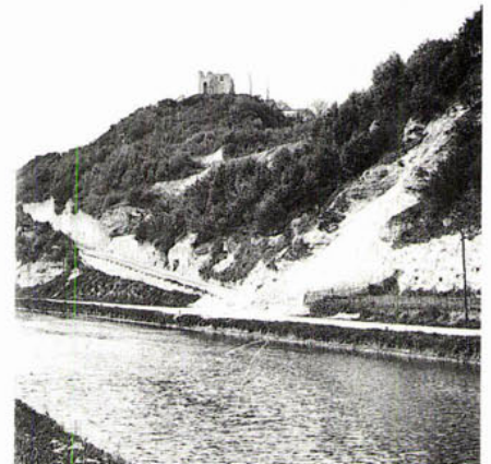
FIGUUR 13d. De ten behoeve van het kanaal afgegraven oosthelling met de Wilhelminaweg en de ruïne Lichtenberg rond 1900. Op de kale helling die is ontstaan door het transport van losse mergel was toen nog een restant typische kalkvegetatie aan te treffen (GRAATSMa, 1987b). Op deze plaats is de E.N.C.I. in 1926 begonnen met haar grootscheepse winning van kalksteen waardoor dit deel van de oostelijke helling later volledig verdween. Foto: kollektie B. Graatsma.
