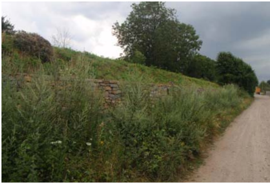
Fout: door woekering van de vegetatie kruiden worden de muren en bodem te weinig zonbeschenen (foto Frank Spikmans).
