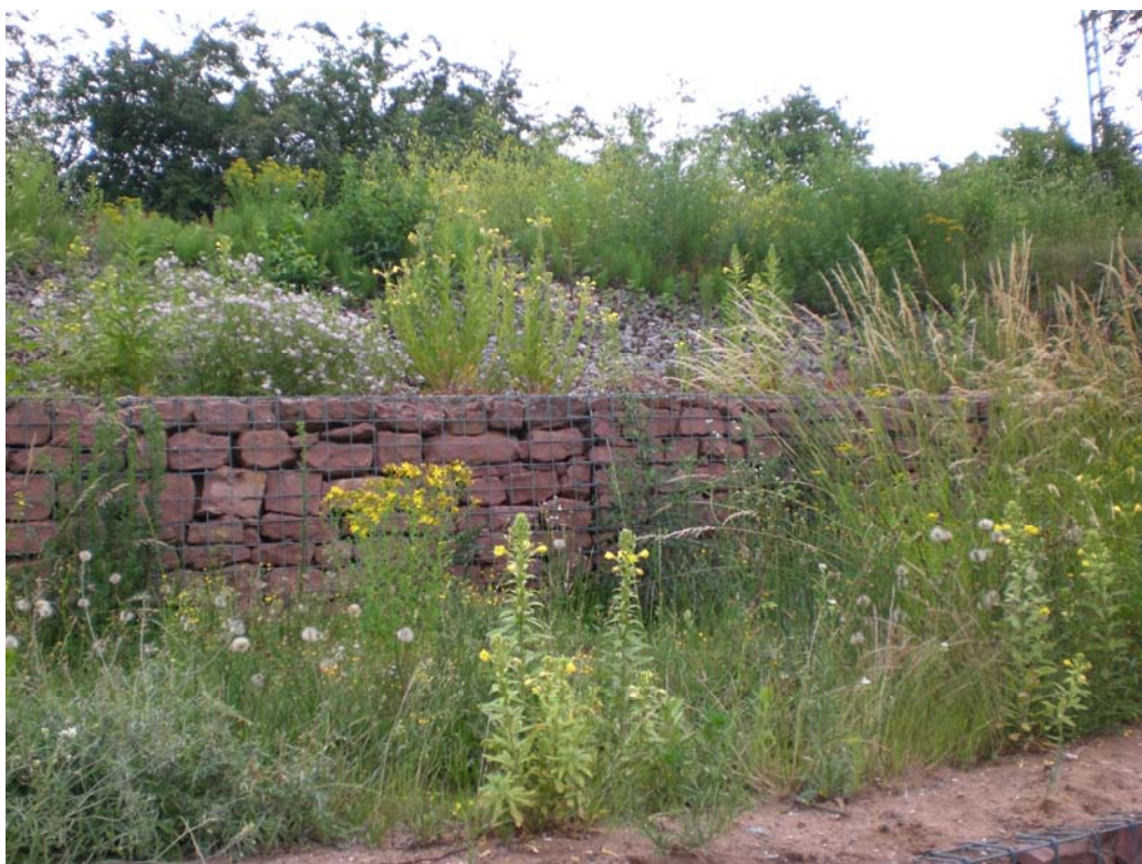
Figuur 13. Steenkorven zoals toegepast in Heidelberg (Duitsland) als nieuw leefgebied voor de muurbagedis. Door steenkorven tegen een talud te plaatsen en een kruidenrijke vegetatie naast te muur te ontwikkelen, ontstaat een volwaardig leefgebied voor de soort (foto Judith Jacobs).
