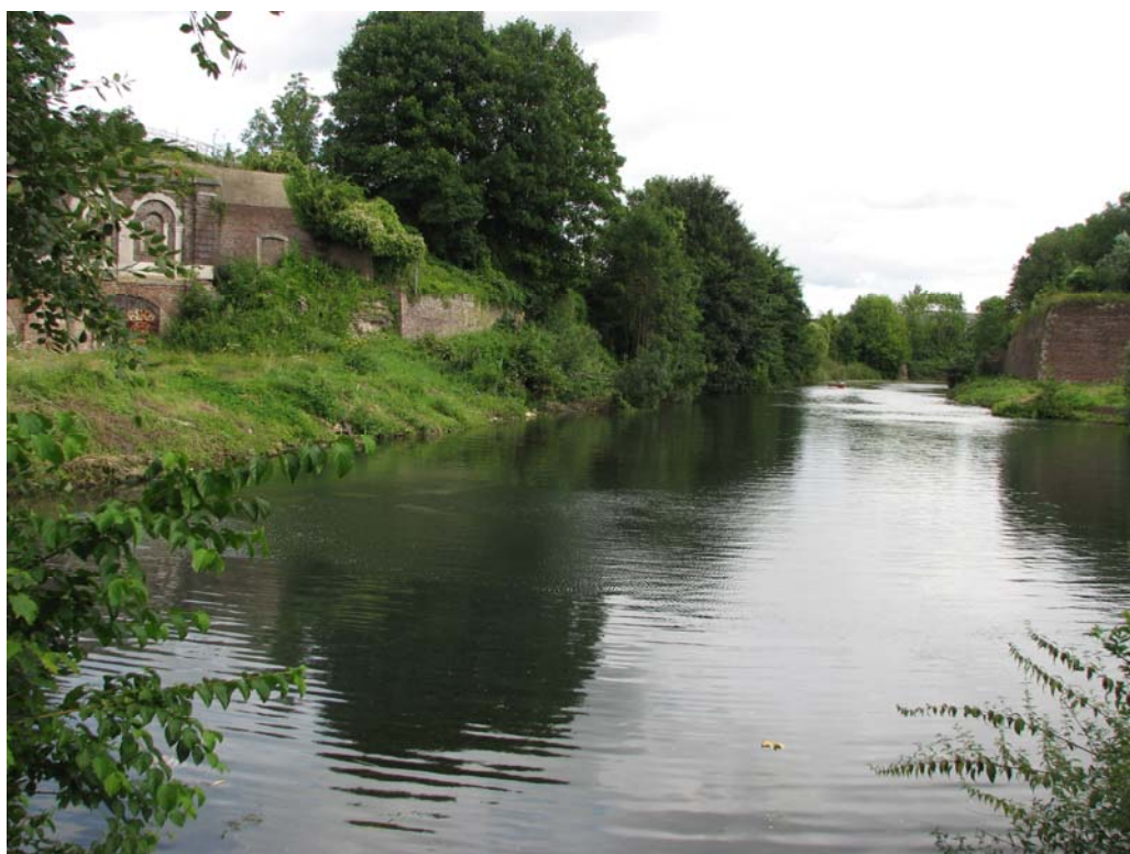
De Lage Fronten anno 2012. Oude muren, zoals rechts de Kazemat A zijn belangrijk voor de muurbagedis. Door achterstallig beheer zorgen struiken en bomen voor beschadiging van muren zodat ze niet meer geschikt zijn voor muurbagedis.
