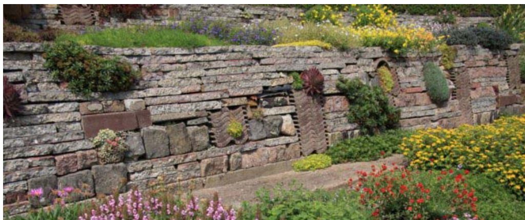
Figuur 10. Voorbeeld van een stapelmuur gemaakt met hergebruikte stenen, dakpannen en beton (afbeelding www.eendijkvaneentuin.nl )
