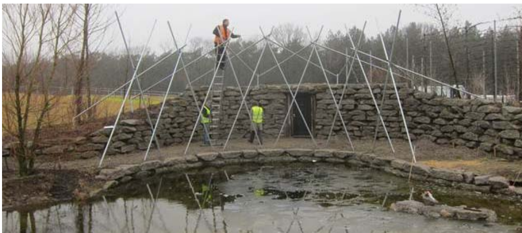
Figuur 9. Voorbeeld van een stapelmuur gemaakt met hergebruikt asfalt (Wilde Weelde, Floriade 2012, foto website Wilde Weelde)
