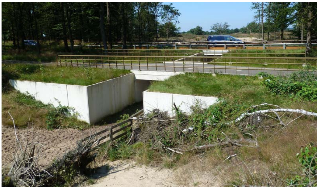
Figuur 19. Passages voor reptielen dienen robuust en open te zijn, waarbij het leefgebied tot in de tunnel doorloopt (voorbeeld herpetoduct Elspeetsche Heide, foto Steven Janssen).
