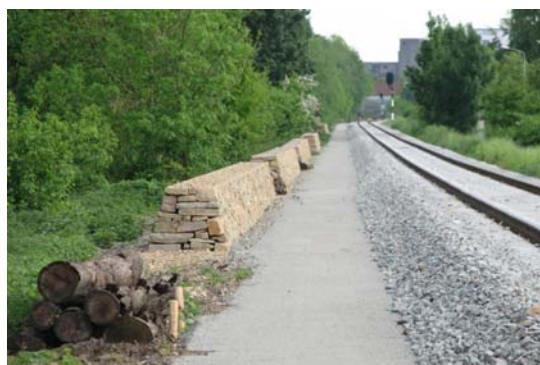
Figuur 11. Stapelmuren zoals deze gerealiseerd zijn naast de spoorlijn Maastricht – Lanaken.
